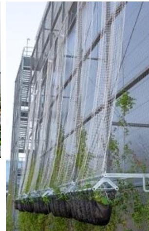
Equinix Germany GmbH Fassadenbegrünung Serverfarm
