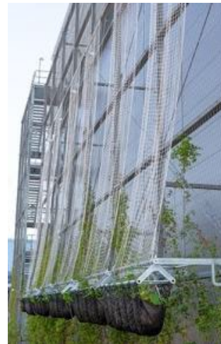
Equinix Germany GmbH Fassadenbegrünung Serverfarm
